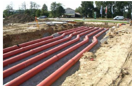
Abbildung 2: Sole- bzw. Luft-Erdwärmetauscher für ein großes Mehrfamilienwohnhaus (Quelle: NEI-Detmold) bzw. www.sole-ewt.de )
