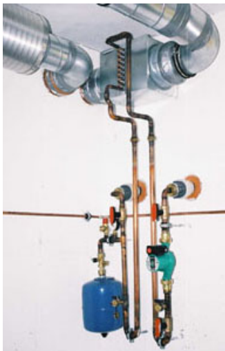
Abbildung 7: Sole-Luft-Wärmetaucher (NEI-Detmold) bzw. www.sole-ewt.de
