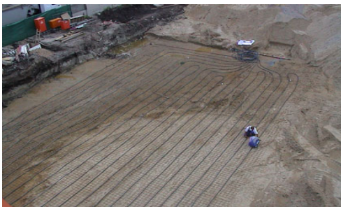
Abbildung 2: Sole- bzw. Luft-Erdwärmetauscher für ein großes Mehrfamilienwohnhaus (Quelle: NEI-Detmold) bzw. www.sole-ewt.de )
