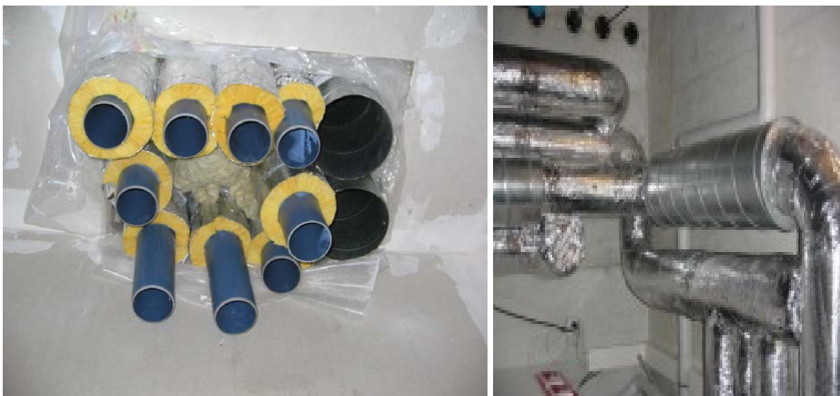
Abbildung 3: Dämmung warmer Luftleitungen im kalten Bereich mit Mineralwolle
