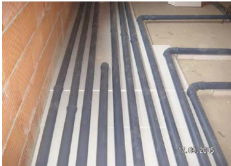
Abbildung 4: Dämmung der Luftleitungen zur kalten Kellerdecke (Quelle: Poloplast)
