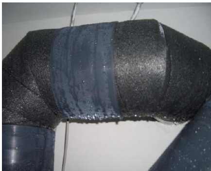
Abbildung 6: Kondensattropfen auf einer zu schwach gedämmten Außenluftleitung im Keller
