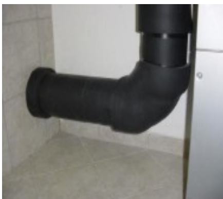
Abbildung 7: Dämmung der kalten Außenluftleitung mit einer feuchtegeeigneten Dämmung (z.B. Armaflex)
