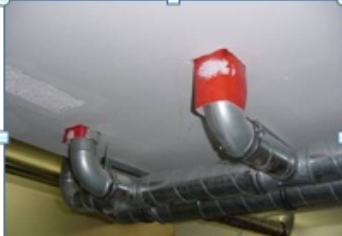
Abbildung 2: PE-Schlauch zur Entkopplung der Luftleitung vom Baukörper
