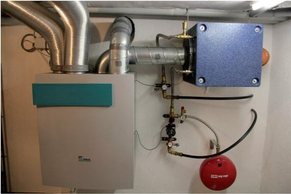
Luftleitungen in der Kellerdeckendämmung: Bei einem Neubau würde man die Leitungen in die Betondecke integrieren. Die geringe Luftmenge von 13 m<sup>3</sup>/h pro Schlauch (DN 75) sorgt für einen geringen Gesamt-druckverlust (40 Pa) und einen leisen Betrieb.
