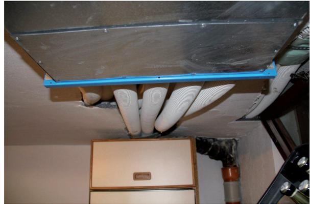
Sole Erdwärmetauscher mit davorliegendem F7 Z-Line Filter. Bei Außentemperaturen unter 5°C bzw. über 22°C schaltet sich die Pumpe des Sole-Erdwärmetauschers ein und erwärmt die Außenluft im Winter und kühlt sie im Sommer.
