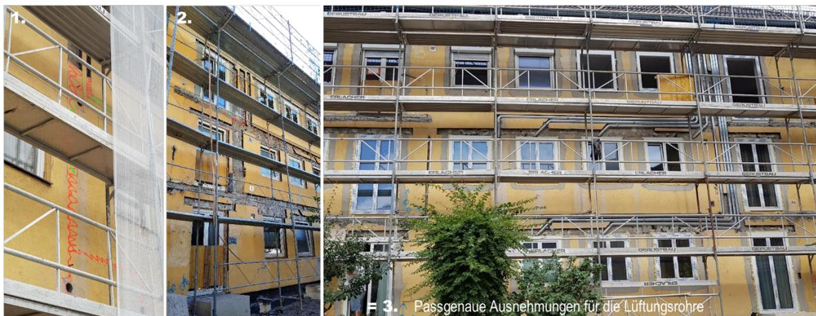
Abbildung 8: die 3 Schritte zur passgenauen Montage der Lüftungsrohre in der Dämmebene, Bildquelle: NHT/Malzer
