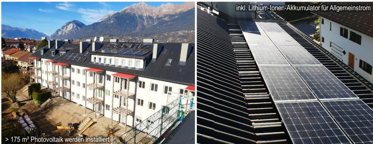
Abbildung 11: Montage der PV-Anlage, NHT/Gassner
