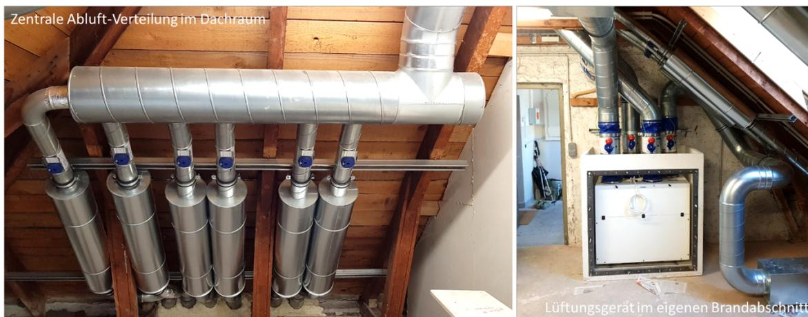
Abbildung 5: Installation der zentralen Lüftungsanlage Pichler LG500 Ventech im Dachgeschoss, Bildquelle: NHT/Malzer
