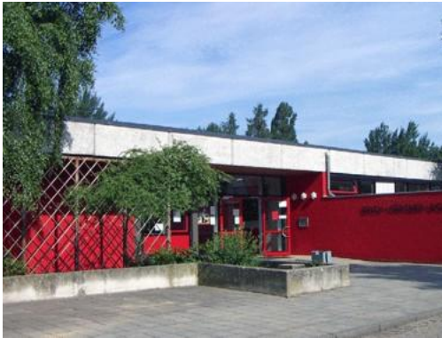
EK GS Haupteingang/ Nordansicht
