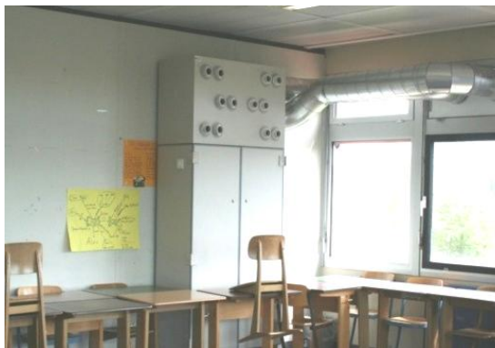
Abb. 35 Lüftungsgerät C
