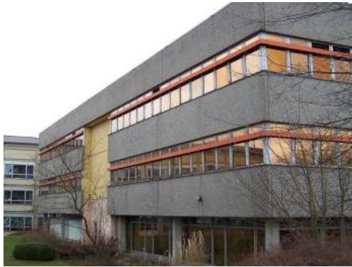
Abb. 31 SZ FL Nordostansicht
