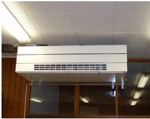
Abb. 29 Lüftungsgerät Typ A
