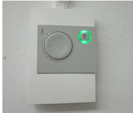
Abb. 34 Bedieneinheit Lüftungsgerät Typ B
