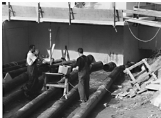
Abb. 13: Erdwärmetauscher einer großen Wohnanlage
