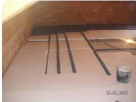
Starre Luftleitungen im Bodenaufbau (Quelle Poloplast)
