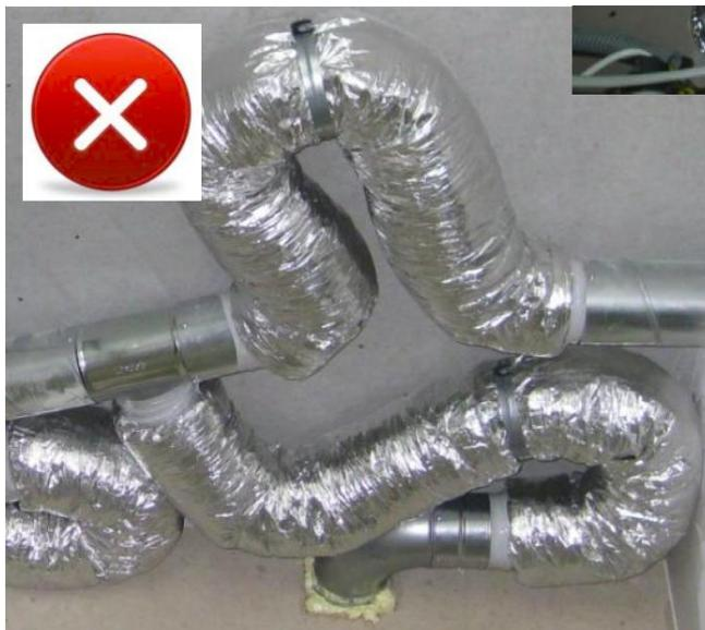
Abbildung 21: Beispiel eines nicht reinigbaren Leitungssystems in einer Zwischendecke (Leitzinger, 2013)
