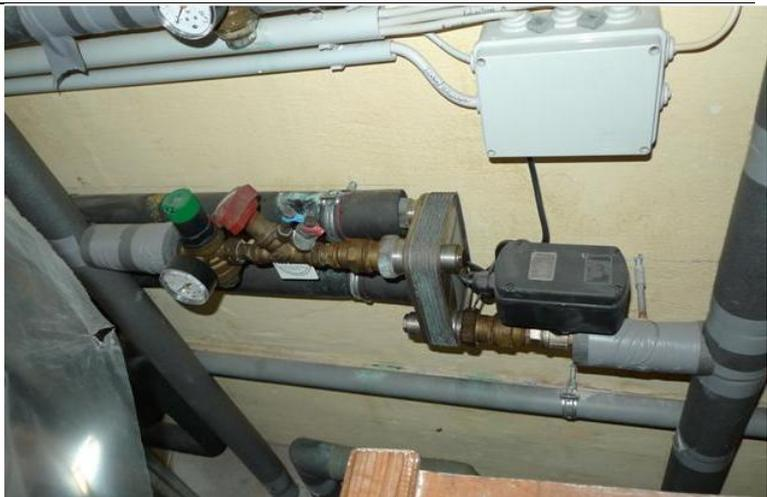
Abbildung 39: offensichtlich zu klein dimensionierter Plattenwärmeübertrager Grundwasser - Sole (Leitzinger, 2013)
