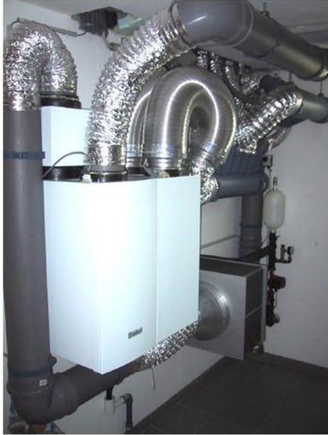
Abbildung 42: hochflexible, undämmbare Außenluft- und Fortluftleitungen in einem Einfamilienhaus (Leitzinger, 2013)
