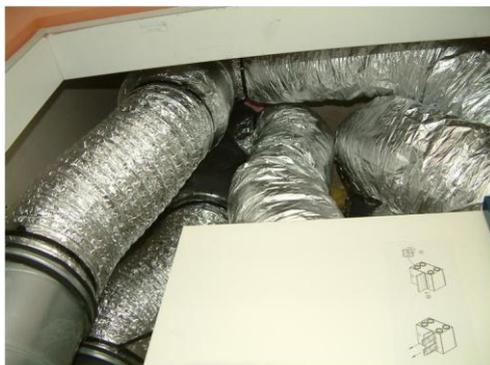
Abbildung 41: undämmbare hochflexible Außenluft- und Fortluftleitungen (links) in einem engen Haustechnikschacht in einer kleinen Wohnhausanlage (Leitzinger, 2013)
