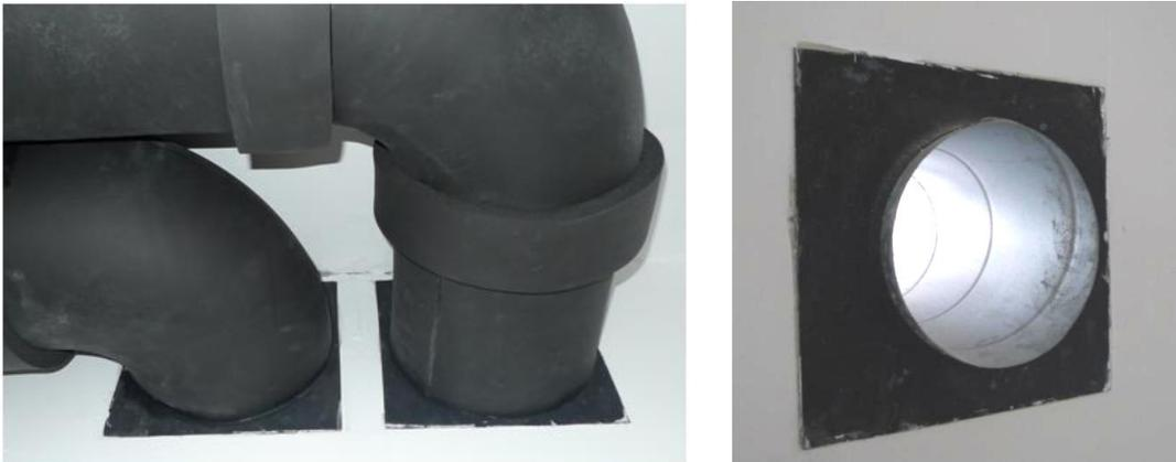
Abbildung 6: rechteckige EPDM-Gummimanschetten für luftdichte Außenwanddurchführung von Lüftungsrohren
