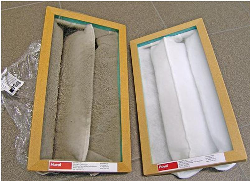
Abbildung 14: Abluftfilter einer Wohnraumlüftung links nach einem Jahr, rechts neu
