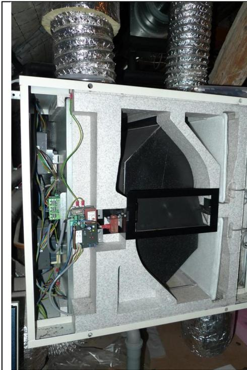
Abbildung 38: Gerätinnenseite mit Plattenwärmetauscher und störanfälliger Bypassklappe (Leitzinger, 2013)
