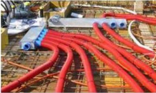
Flexible Luftleitungen in der Betondecke (Quelle: Nilan)
