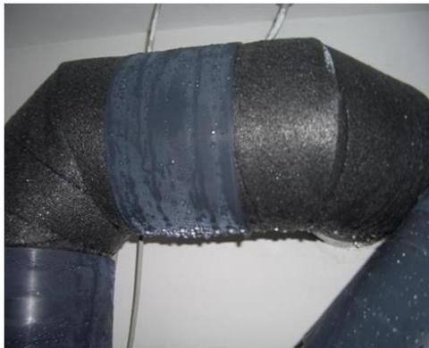
Abbildung 40: Kondensatbildung an einer geschäumten Luftleitung in einer Reihenhausanlage (Leitzinger, 2013)
