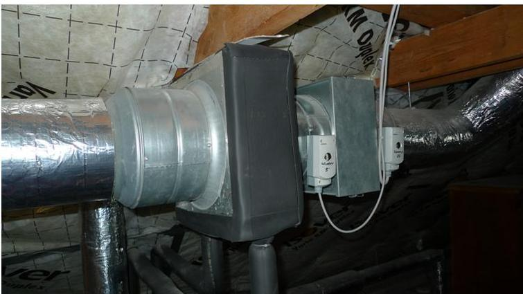
Abbildung 37: Heizregister statt Kühlregister verbaut – fehlender Kondensatablauf (Leitzinger, 2013)
