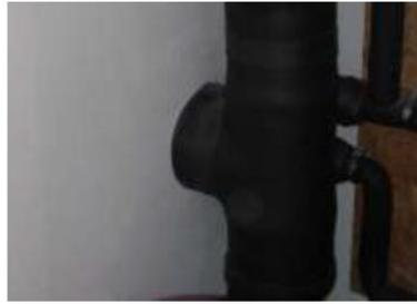
Abb. 3-48: Gedämmte Außenluft Leitung mit EWT Gefälle zum Technikraum und „Kondensatwanne“ mit z.B. Kugelsiphon
