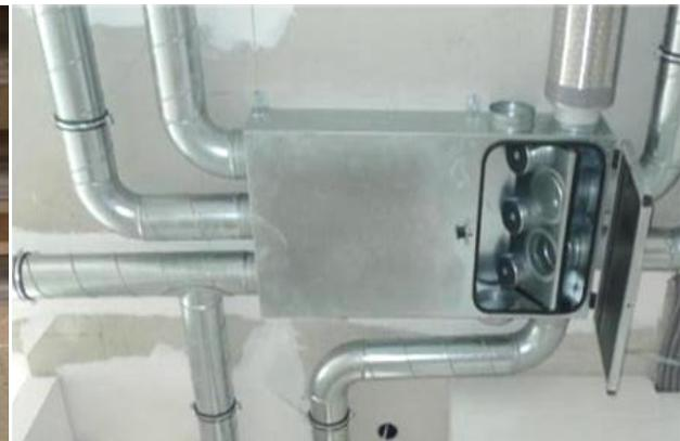
Abbildung 30: Kombinierte Verteilbox für Zu- und Abluft zur Auskreuzung von Luftleitungen
