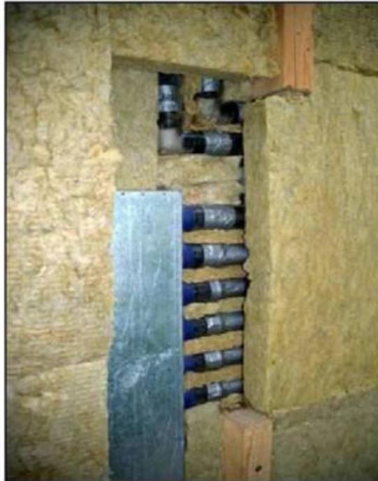
Abbildung: Leitungsführung in der Außendämmung (Quelle: AWEL)
