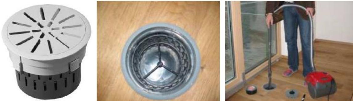
Abb. 3-51a; b; c: Fußbodenauslass (Quelle Systemair); Auslass mit verlegtem Boden; Reinigung des Bodenauslasses im Zuge der Luftmengen-Einmessung
