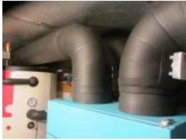
Abb. 3-47: Gedämmtes Außen- und Abluft Rohr mit lückenlosem Dämm-Anschluss am Gerät im „kalten Technikraum“
