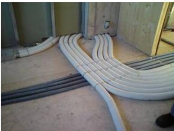
Flexible Luftleitungen im Fußbodenaufbau
