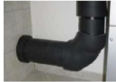
Abb. 3-46: : Gedämmte Außenluft Leitung im kalten Technikraum mit EWT Gefälle Richtung Wartungsschacht im Freien
