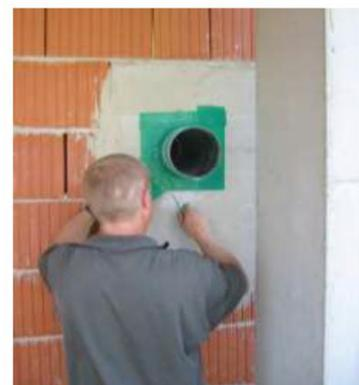
Abb. 3-74: Fortluftdurchführung durch Ytongfeld
