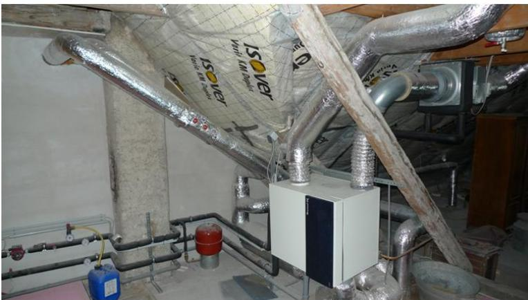
Abbildung 36: Lüftungsinstallation im nicht konditionierten Dachboden (Leitzinger, 2013)
