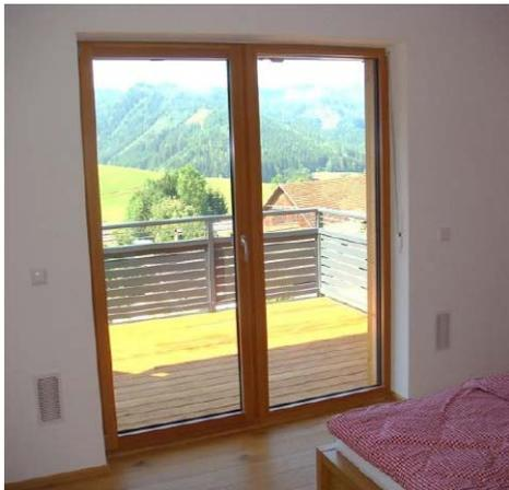
Abbildung 6: Quellluftauslässe an der Wand
