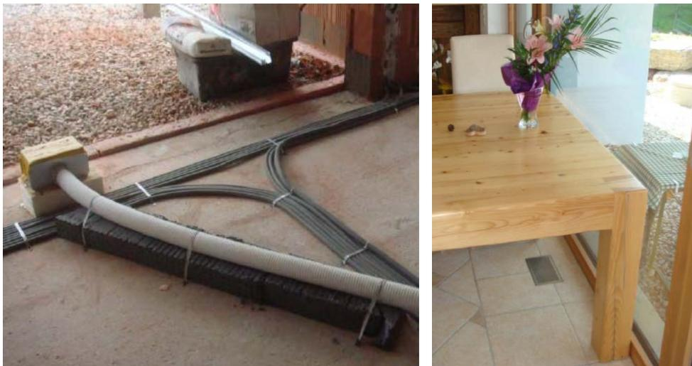
Abbildung 7: Quellluftauslass am Boden (Dämmung unter Luftleitung notwendig wenn sich darunter ein unbeheizter Bereich befindet)
