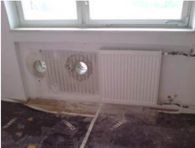
Bild 8: Einbaubeispiel für Lüftungsgerät für Raumkombinationen - Räume könnten natürlich auch abgetrennt sein (Quelle: Fa Paul)
