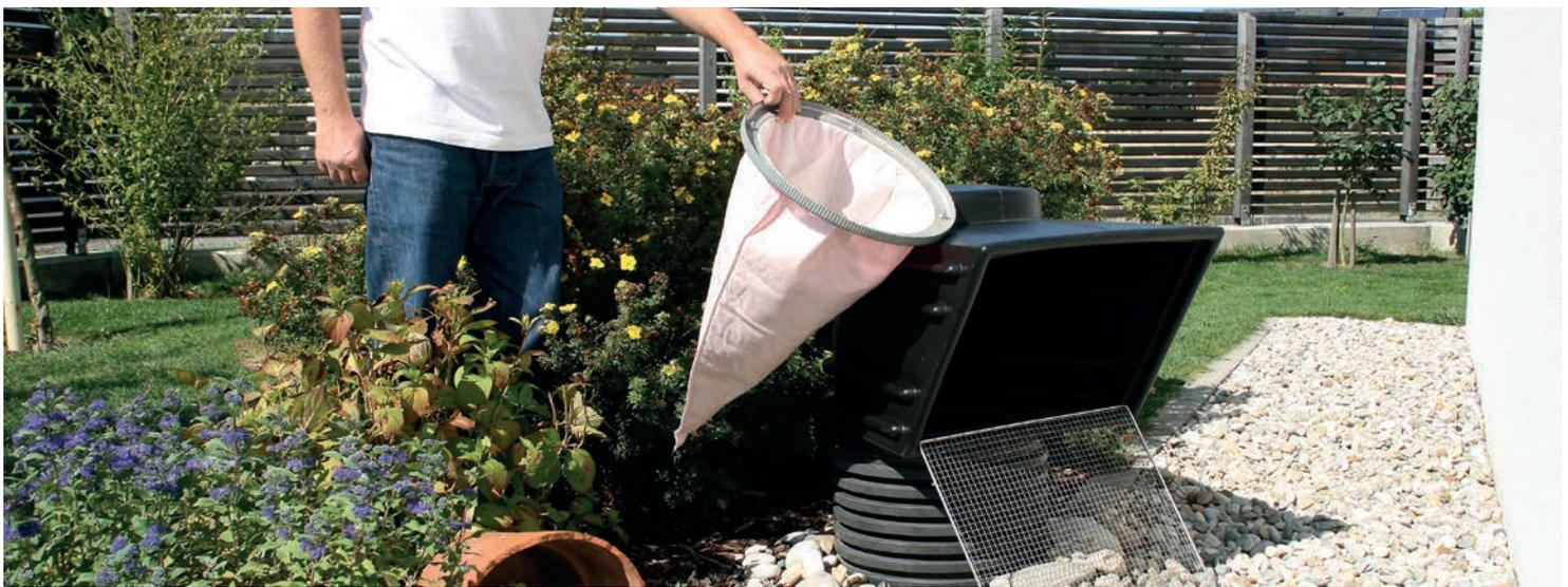
Wechsel des Taschenfilters bei einer Außenluftansaugung
