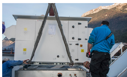
1. Anstieg mit Kran
