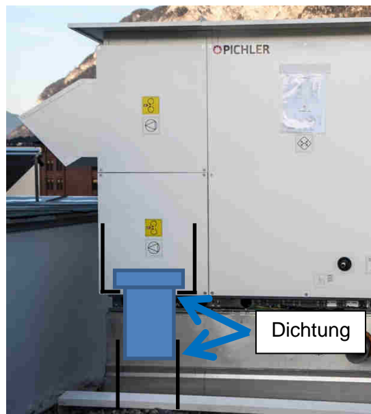
Abbildung 81 Dichtung Anschluss Dach
