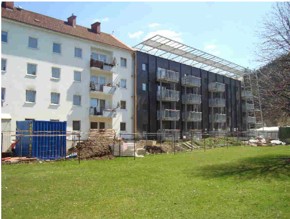
Abbildung 64 Johann-Böhmstraße 34-36 mit nahezu fertig gestelltem Bauabschnitt 1 im Frühjahr 2013
